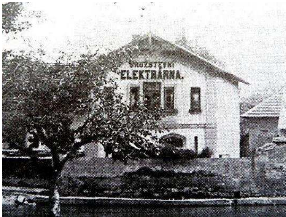
Miletice měly od roku 1908 vlastní elektrárnu a síť do domácností
