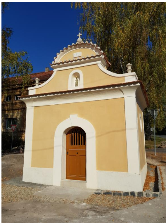
Kaple Panny Marie v Bratkovicích, po rekonstrukci 2018
